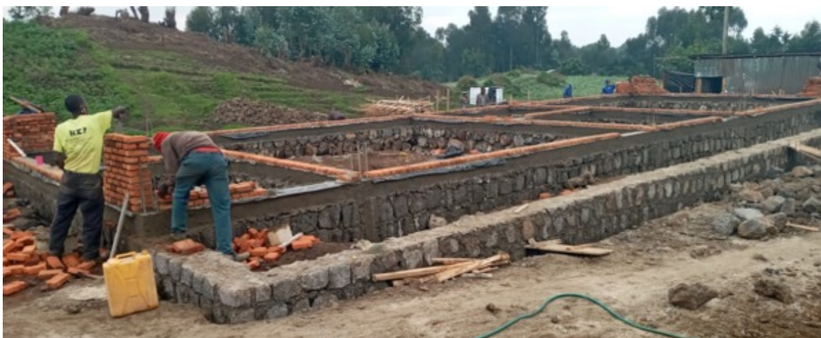
Abb 8: Baubeginn des Future For Kids – Muhisimbi Sewing Centre im Februar 2020, kurz vor Ausbruch der Pandemie
